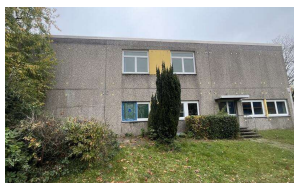
Auf dieser Seite der Hauptschule Süd gab es früher eine Hausmeisterwohnung. In diesem Bereich befinden sich die gesperrten Räume und die hohen Schimmelpilz-Konzentrationen. Foto: Wisser
